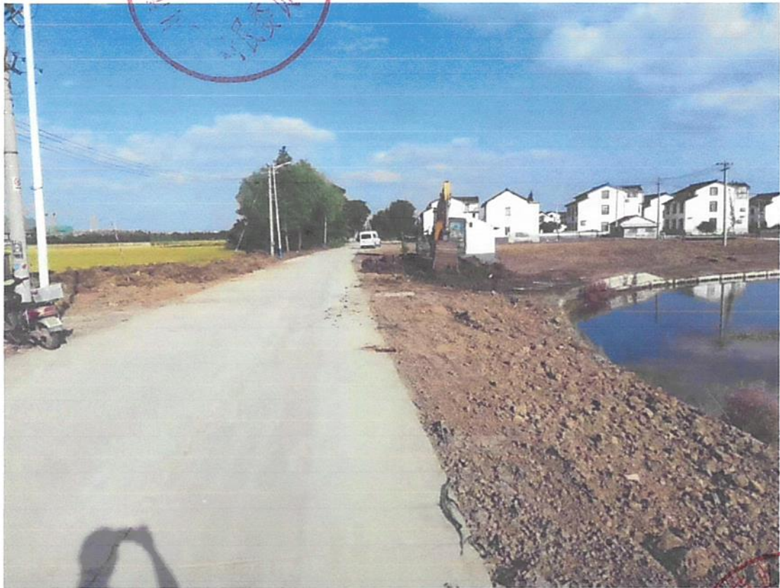
兴复村西洋村西北侧绿化工程施工中照片
