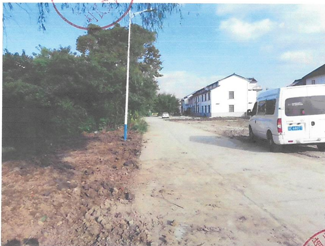
兴复村西洋村西北侧绿化工程施工前照片
