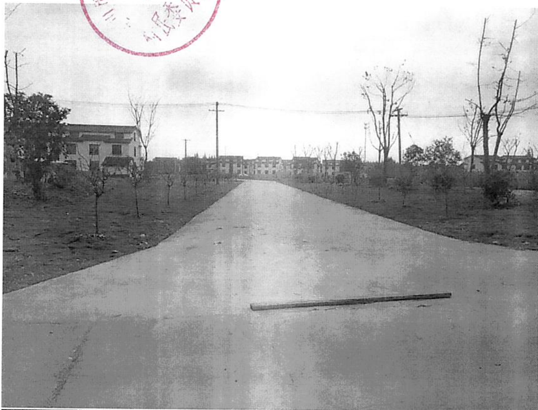
西洋村夏家池环村道路浇筑工程施工后照片
