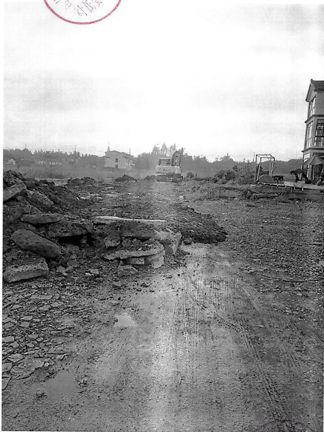
西洋村夏家池环村道路浇筑工程施工照片
