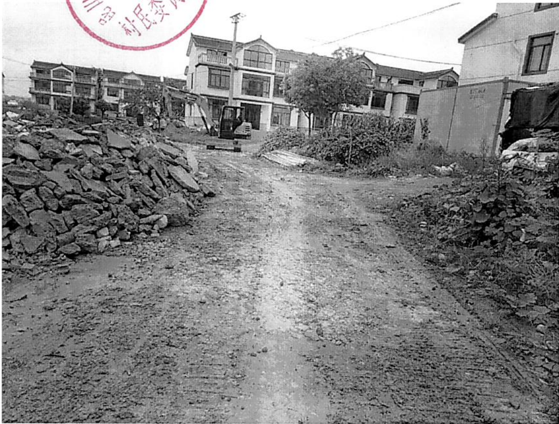
西洋村夏家池环村道路浇筑工程施工照片
